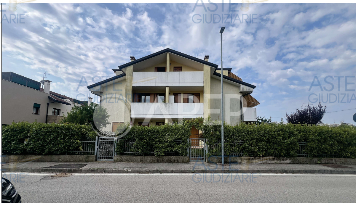
Vista del fabbricato da Nord-Est, via Tazzoli
