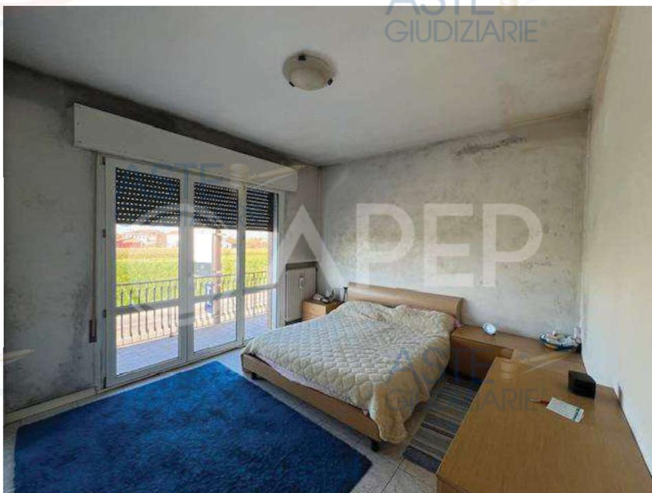
Nel vano è notevole la presenza di condensa da umidità e la conseguente manifestazione di muffe e alterazione superficiale dell'intonaco, fenomeno tipico delle pareti prive di coibentazione esposte a nord.
