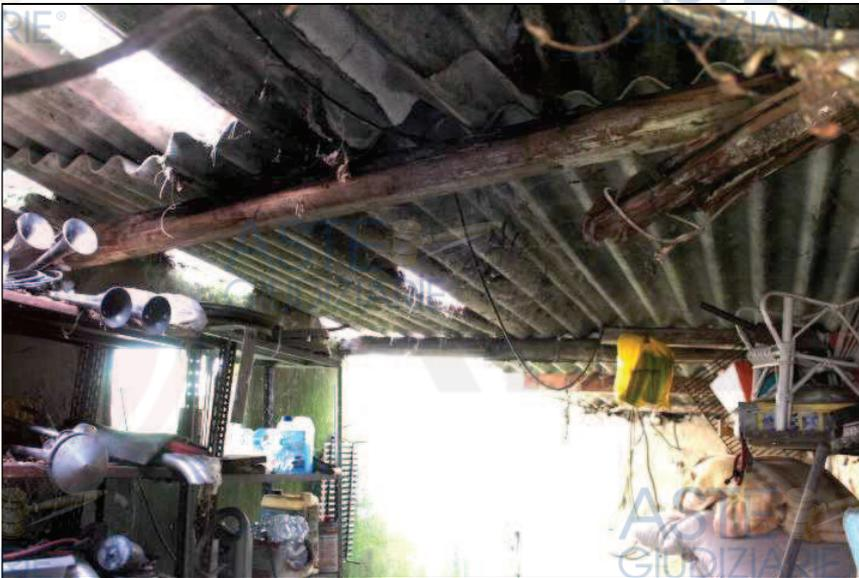
La copertura del ripostiglio e di circa 1 metro di garage è, come detto, in cemento –amianto, e totalmente degradata (veri foto qui sopra; dev'essere pertanto rimossa, smaltita e sostituita.
