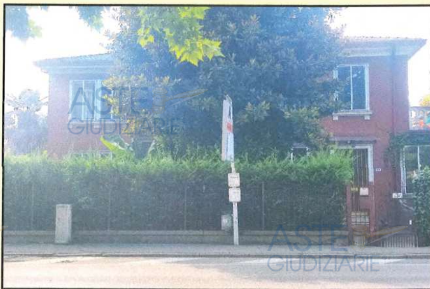
LOTTO 2) - LOTTO 3) casa tipo bifamiliare in Padova, via Cernaia, 40-42
