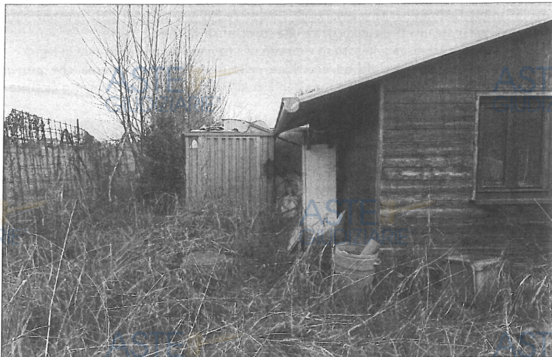
Vista del manufatto a Ovest
