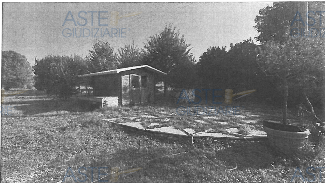
Vista del fabbricato, del pozzo e dello spiazzo a Sud-Est (sopralluogo 29.10.2024)
