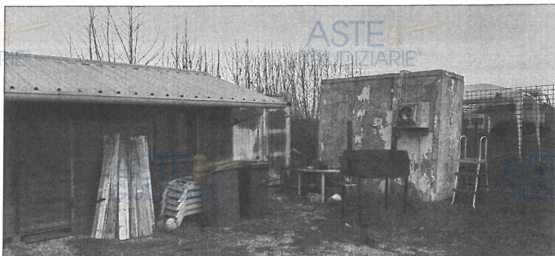
Vista della cella frigo
