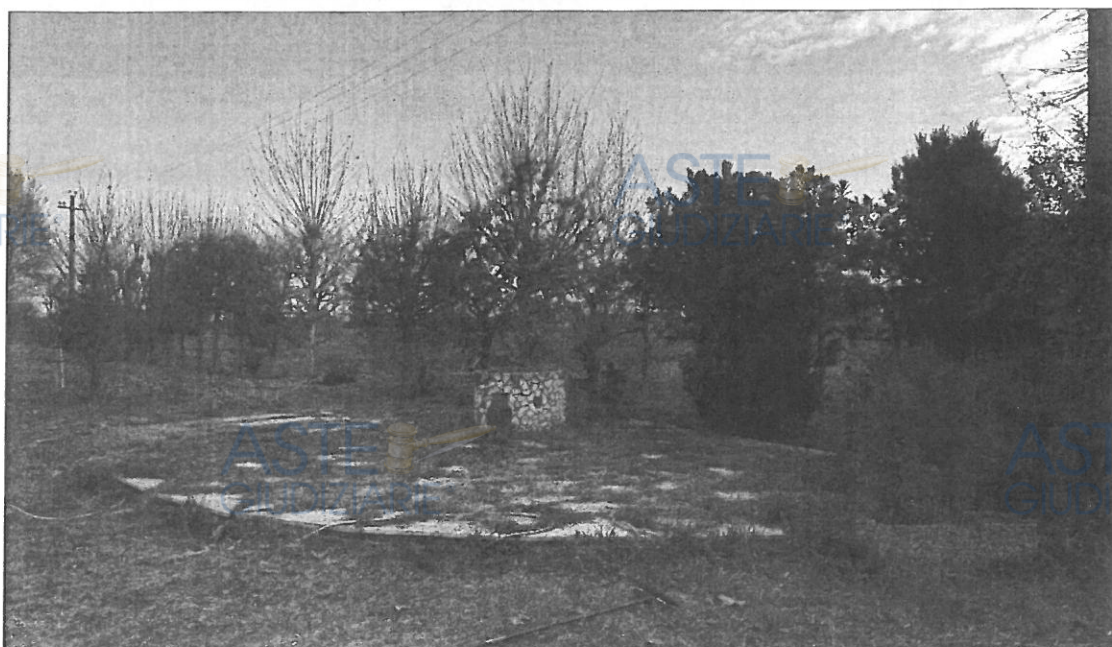
Vista della platea (sopralluogo 20.01.2026)
