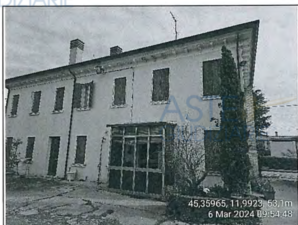
Porzione di abitazione part.563 sub.2
