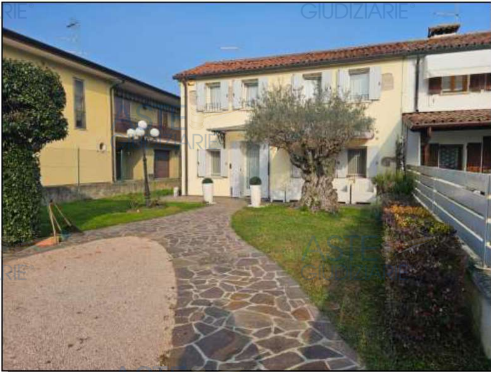
Veduta del fronte principale dell'immobile oggetto di esecuzione immobiliare.
