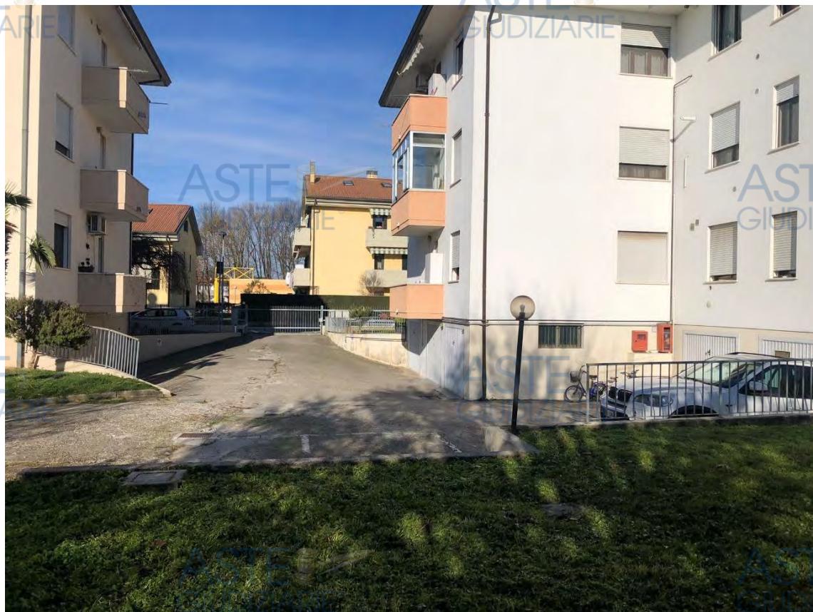
Figura 19 – Corsia di manovra comune ai fabbricati eretti sui mappali 1447 e 1878
