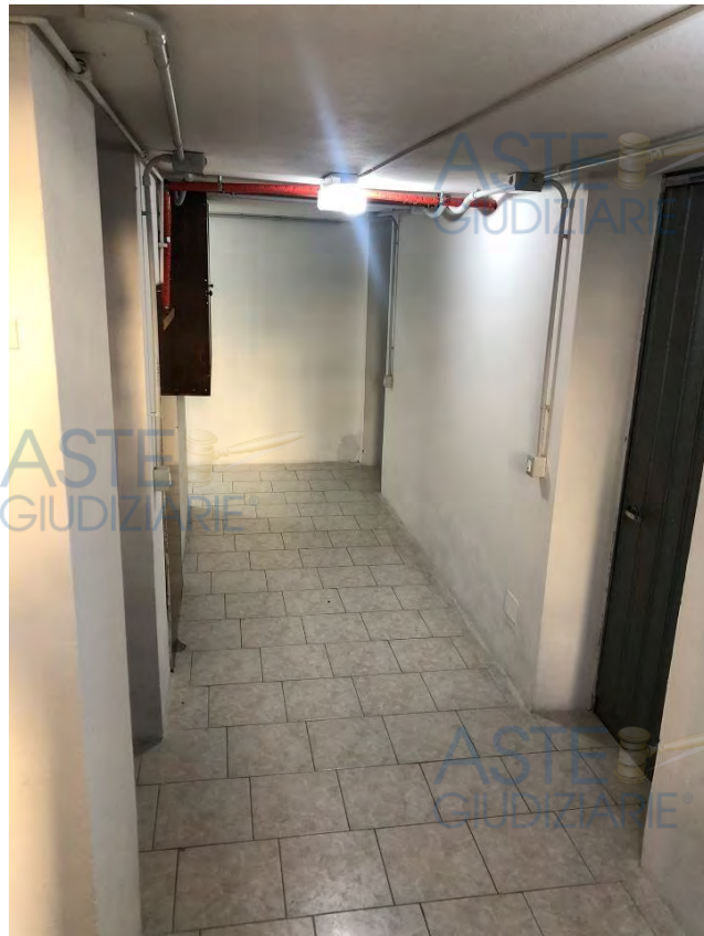
Figura 26 – Corridoio comune a piano interrato
