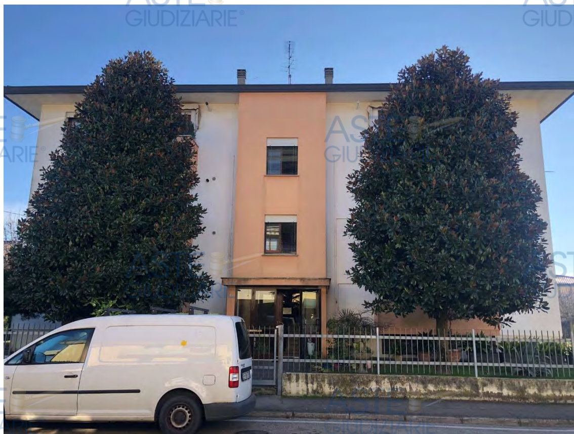
Figura 8 – Facciata su via Mascagni
