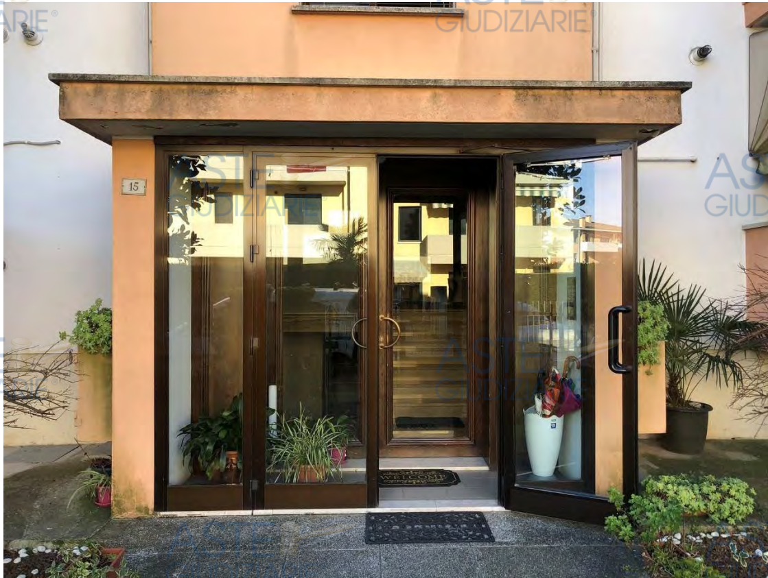
Figura 23 – Ingresso al fabbricato
