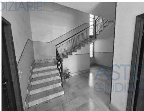
Vano scala condominiale
