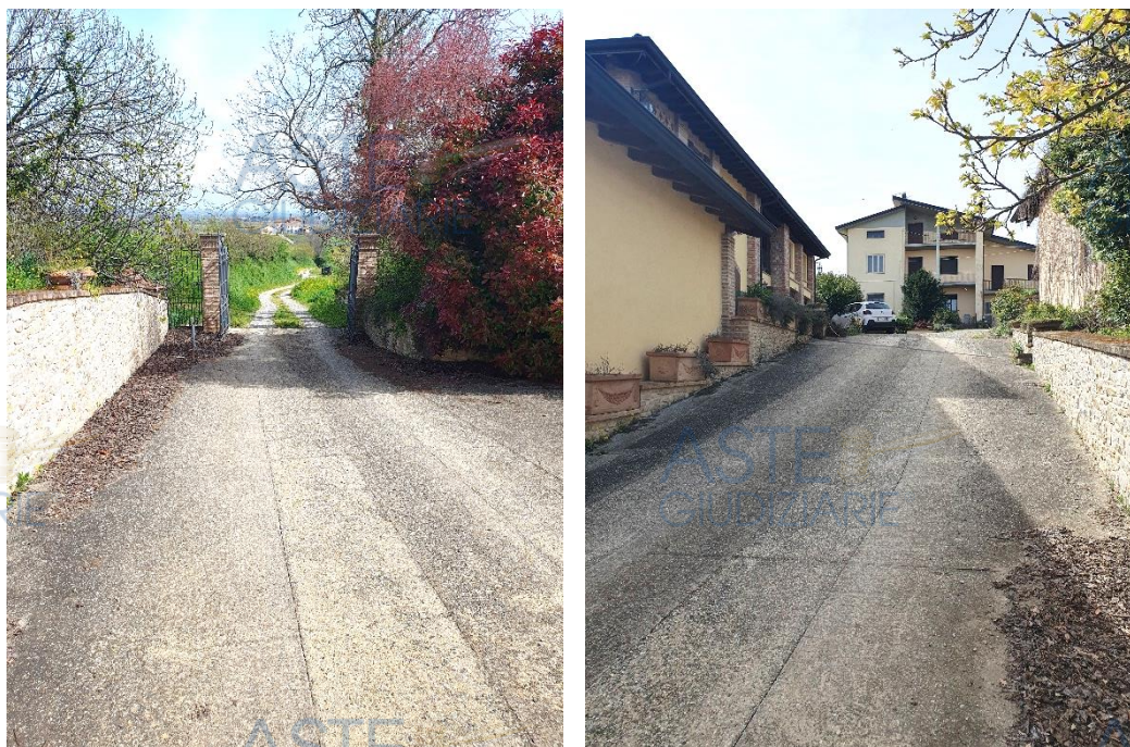
Figura 4 - Foto dell'ingresso all'area cortilizia sulla quale affacciano anche gli immobili oggetto di causa (foto a sinistra: vista verso nord; foto a destra: vista verso sud)
