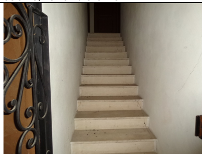
Sub 15, scala accesso alla zona cantina
