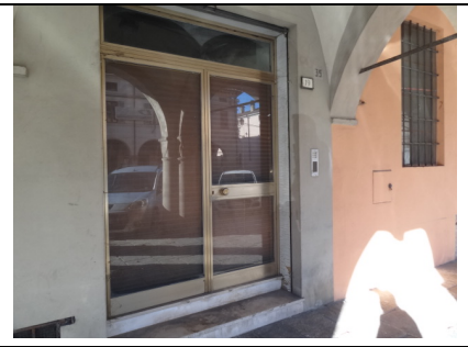
Ingresso da porticato uso pubblico fronte strada
