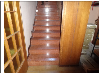
Interno locale commerciale, accesso al corpo scala a servizio delle abitazioni al P1 e P2
