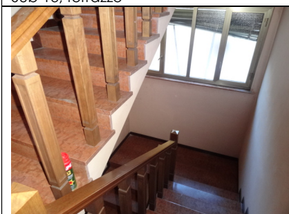
Corpo scala a servizio delle abitazioni al P1 e P2
