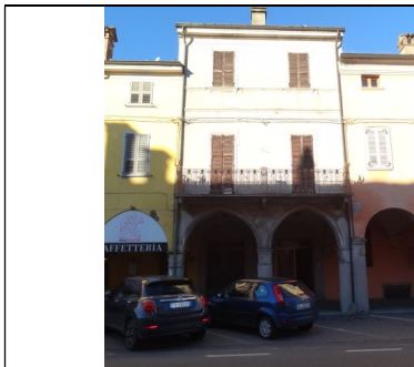
Vista da strada
