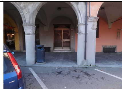
Vista da strada
