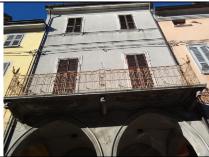
Facciata fabbricato su via Cavour
