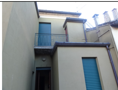
Facciata interna vista da terrazzo p1
