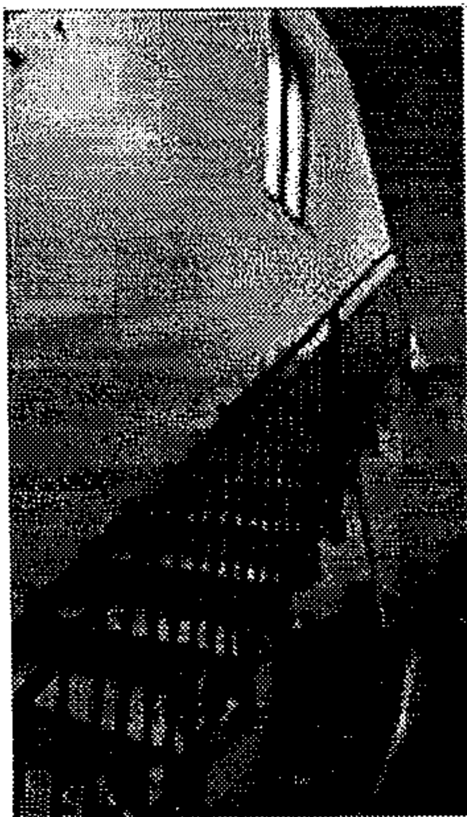
il vano scala comune ai due subalterni
