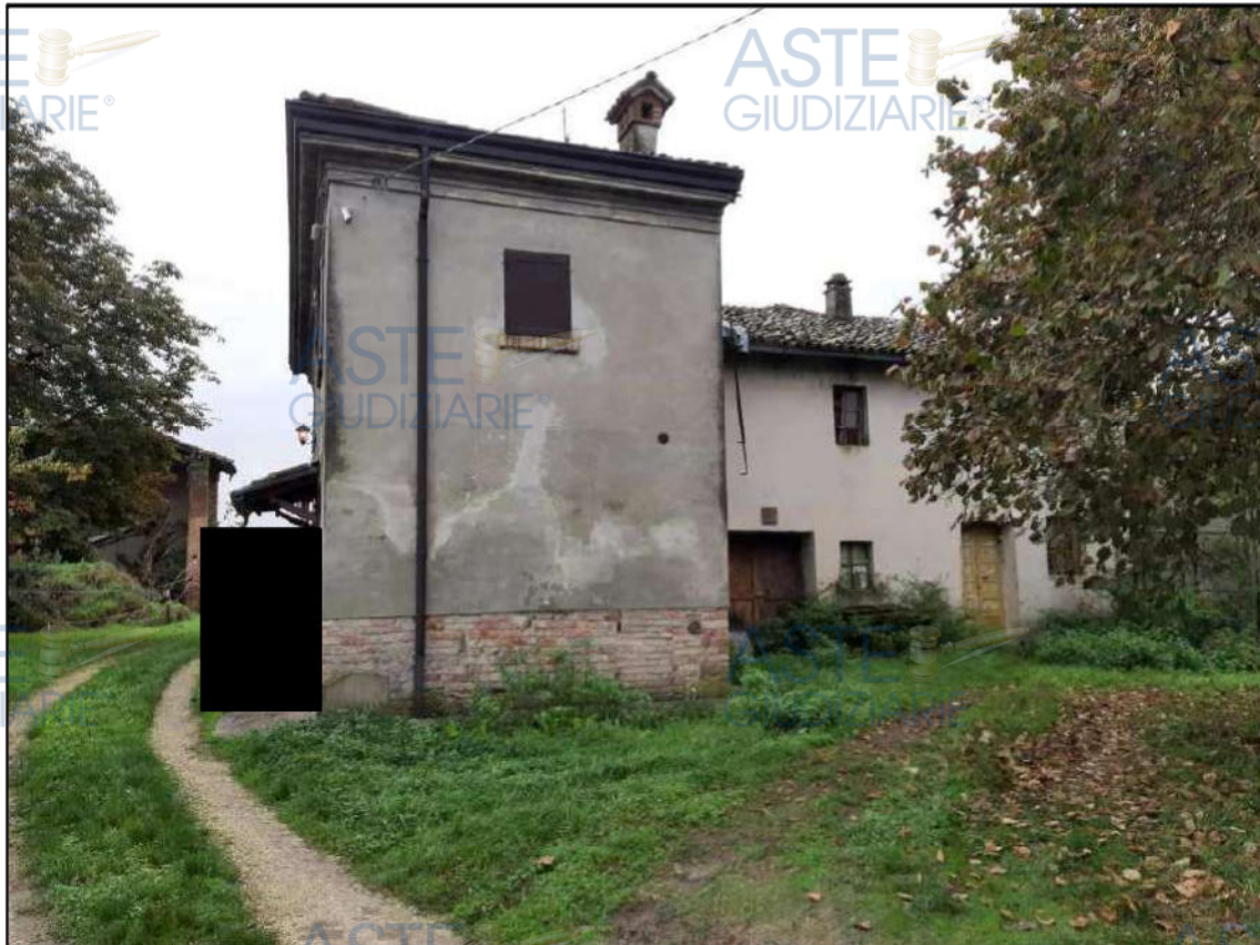
F 2 - Fronte Nord
