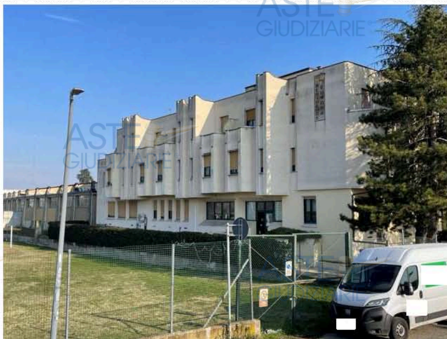
F2: Vista lato ovest (da Via Vaciago)
