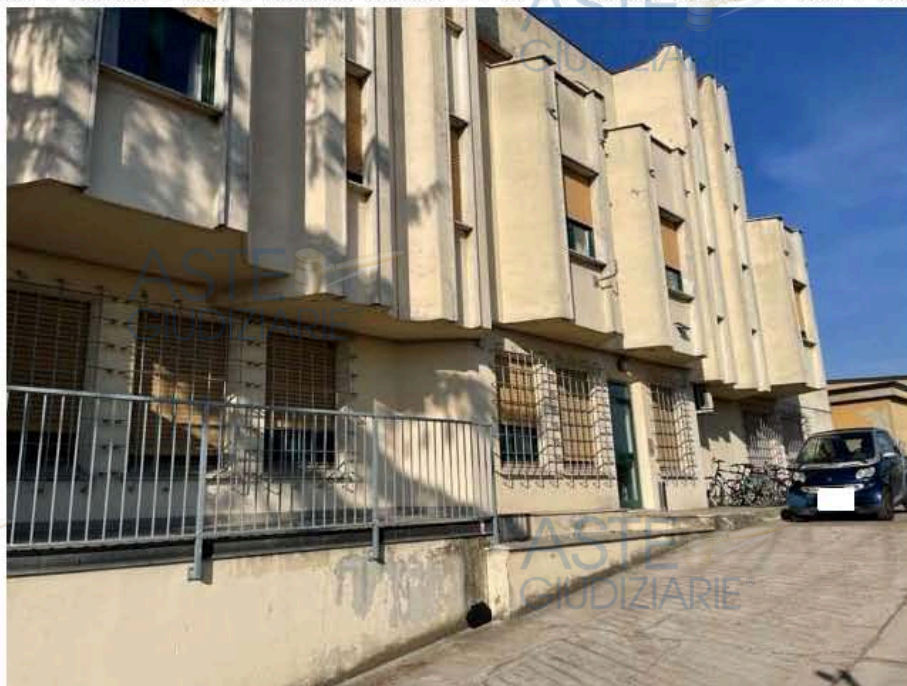
F4: Vista da cortile interno lato est
