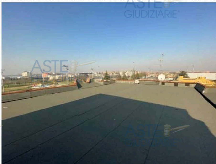
F40: terrazzo di copertura 3° piano attività ricettiva
