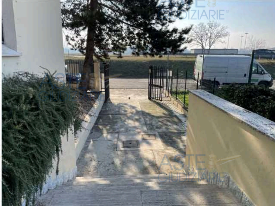
F5: Ingresso pedonale
