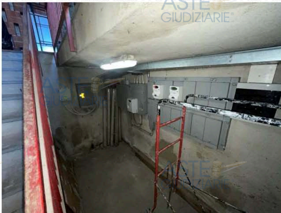
F44: piano seminterrato – scala esterna/locale contatori
