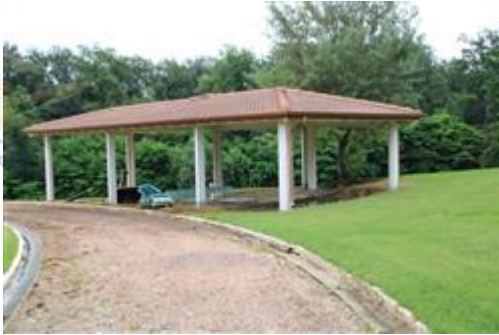
Foto 5: Porticato in cemento armato
