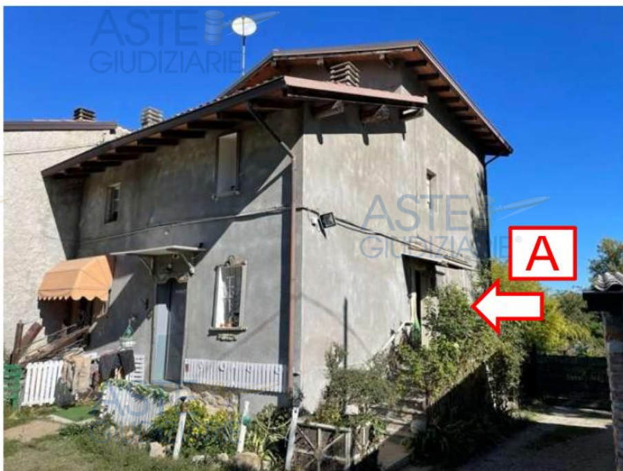
Fot. N. 4: Vista lati Sud/Est
