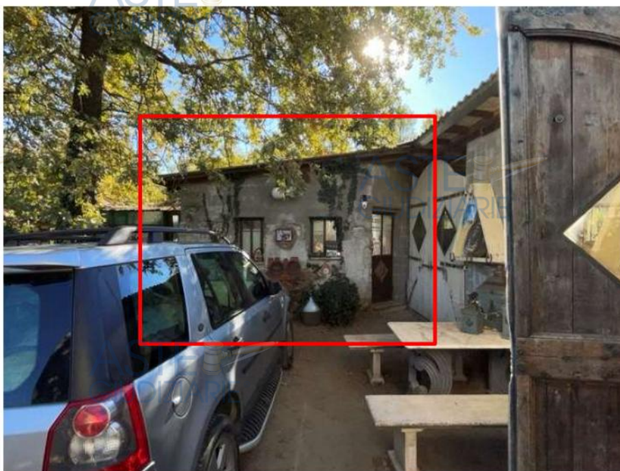
Fot. N. 23: Pertinenza (lato ovest)
