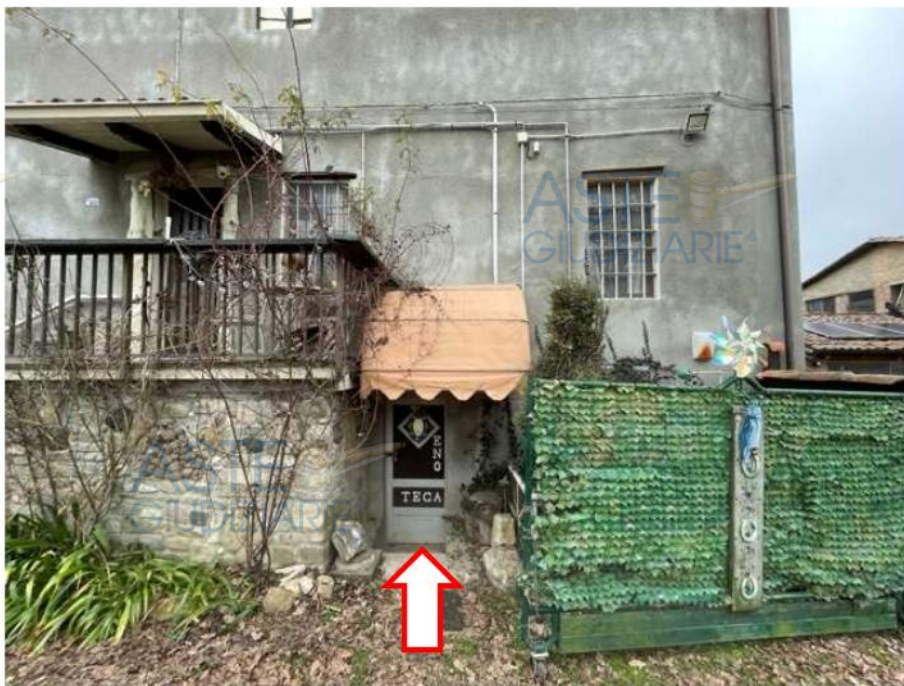
Fot. N. 17: Ingresso cantina (grande)
