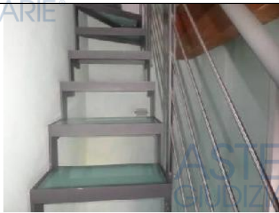
Scala collegamento interna per accesso al locale tecnico
