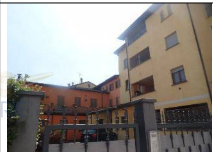
Vista da corte interna
