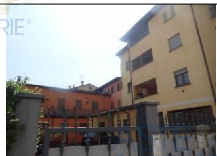
Vista da corte interna
