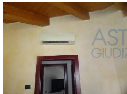
Finiture/dotazione impianti abitazione
