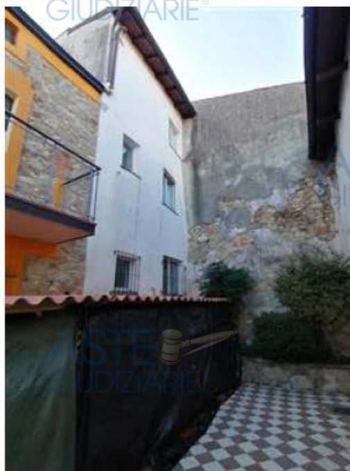
Vista esterna dell'immobile, sul retro
