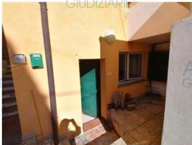
Vista dall'esterno della porta d'ingresso
