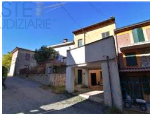
Altra vista dell'immobile dalla strada
