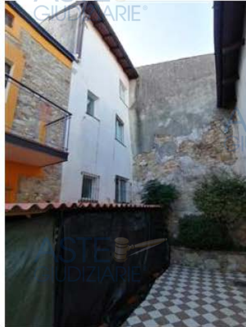
Vista esterna dell'immobile, sul retro
