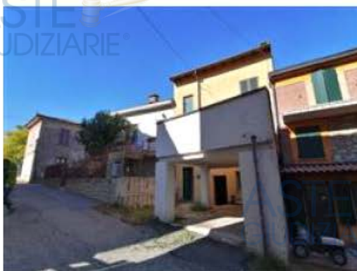
Altra vista dell'immobile dalla strada
