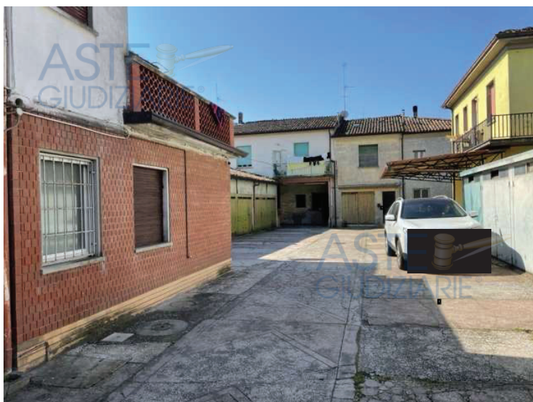
Fot. N. 6: vista sul cortile comune
