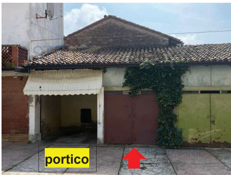
Fot. N. 5: box auto e portico
