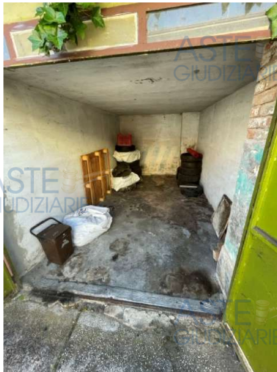
Fot. N. 24: Autorimessa – P. terra
