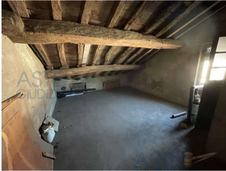
Fot. N. 23: Sottotetto – P. 2°
