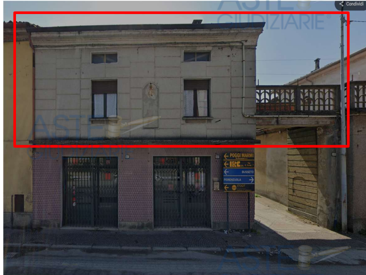
Fot. N. 2: Vista Nord (su Via Matteotti)
