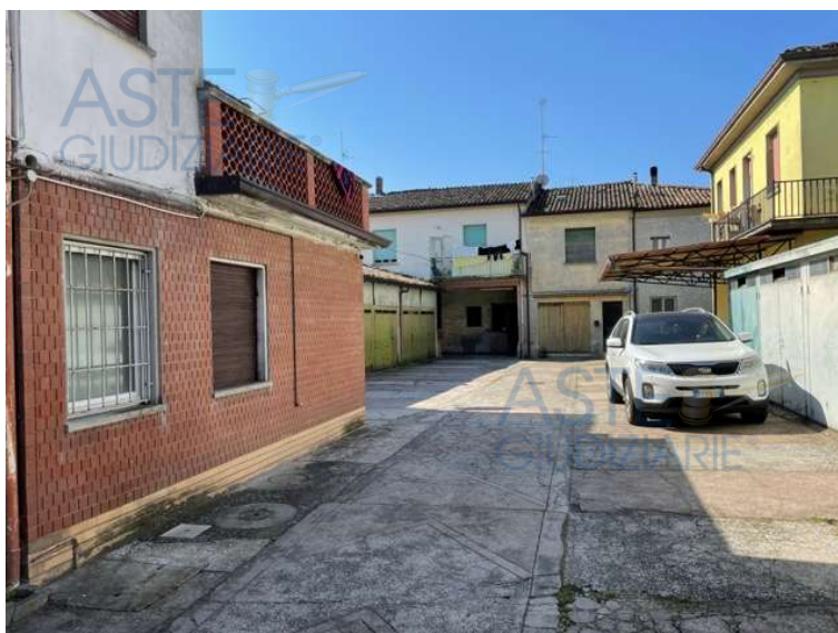
Fot. N. 6: vista sul cortile comune
