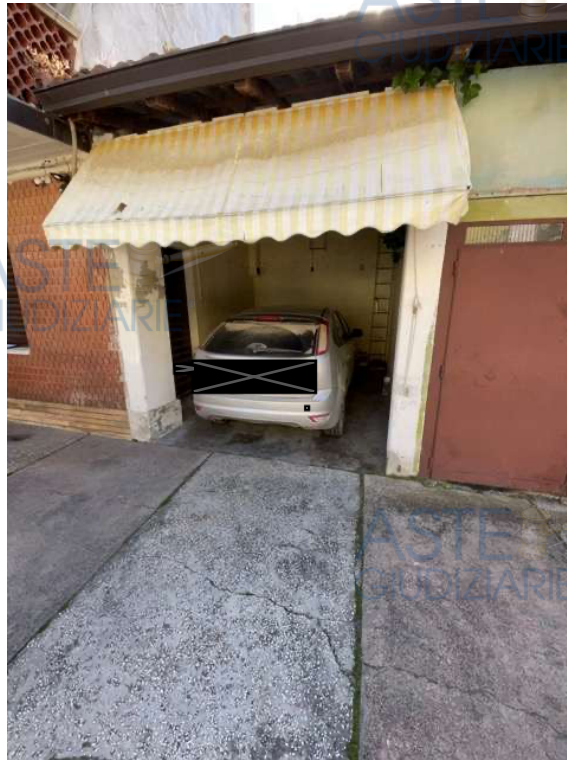
Fot. N. 11: Portico – P. terra
