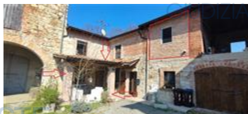
difformità prospetti esterni
