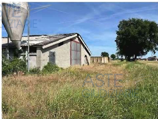
Figura 33 - vista capannone lato sud
