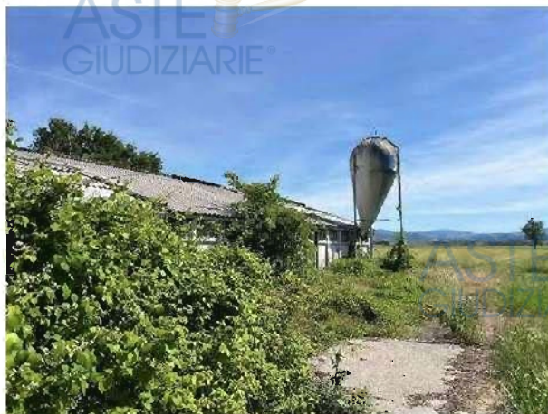
Figura 32 - vista capannone lato ovest
