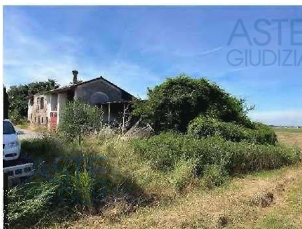
Figura 52 - vista generale complesso
