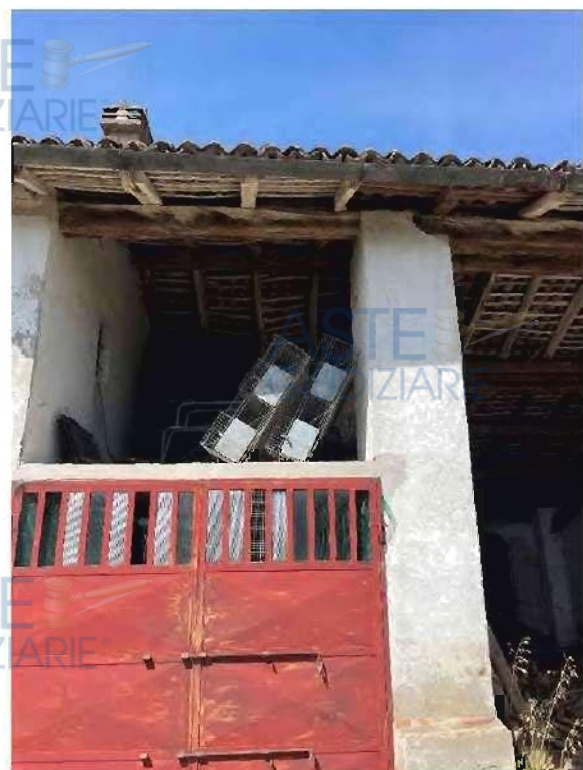
Figura 49 - vista zona autorimessa
