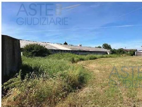
Figura 34 - vista capannone lato est
