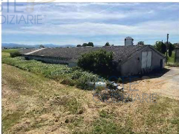
Figura 31 - vista capannone lato nord-est
