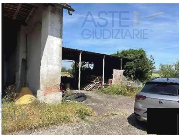
Figura 51 - vista tettoia in ferro
