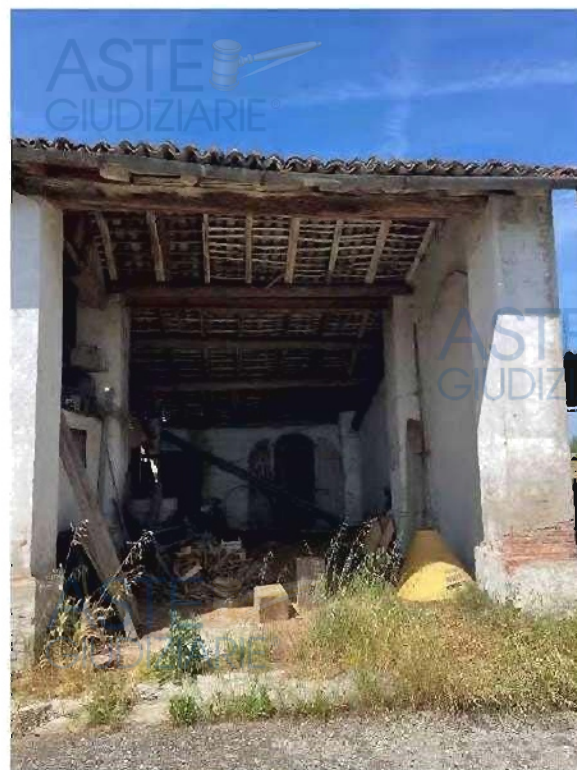
Figura 50 - vista zona portico
