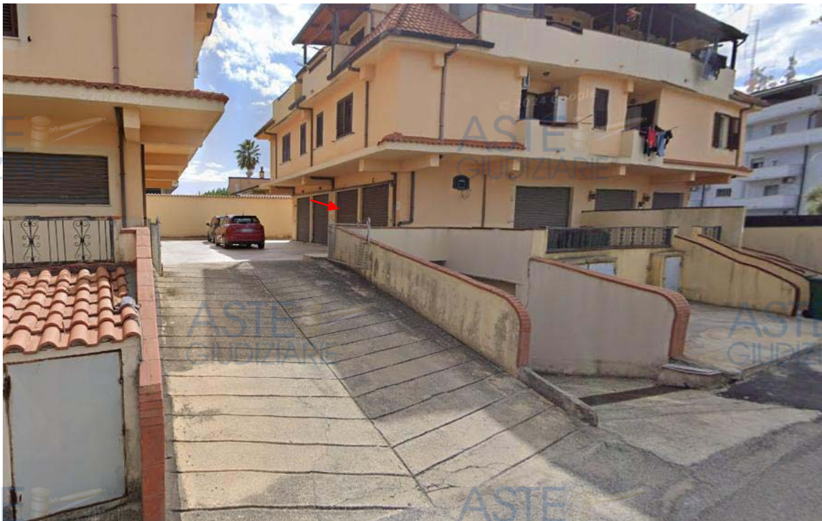
Foto n. 4: Garage part. 721 sub 22- fabbricato corpo "A"
