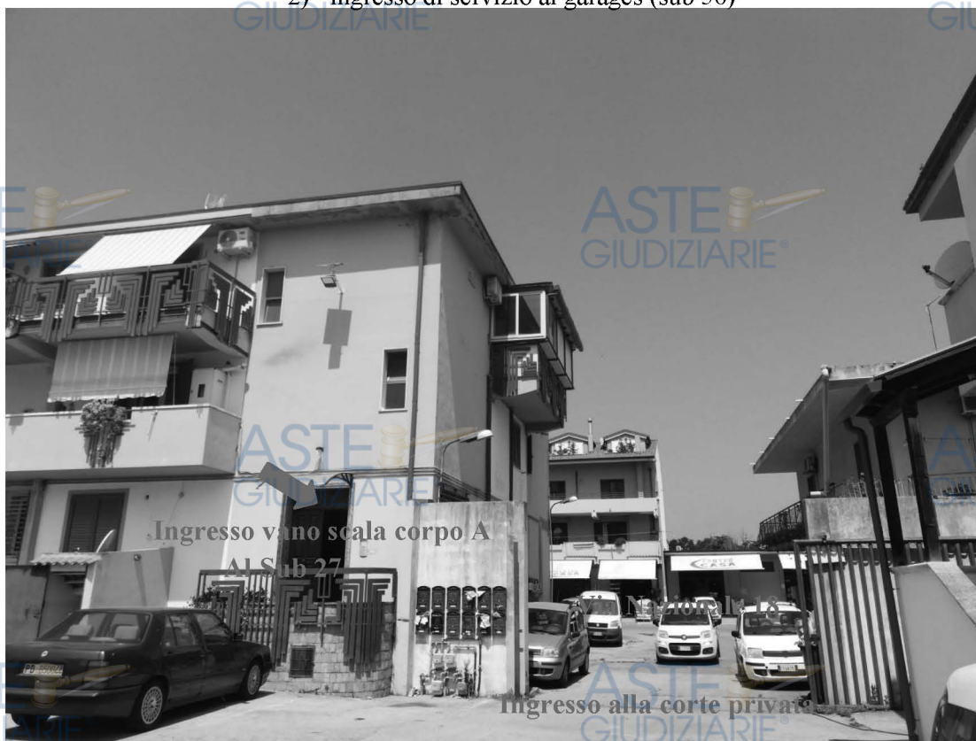
Foto 4_ vista dall'esterno – ingresso scala condominiale corpo A
