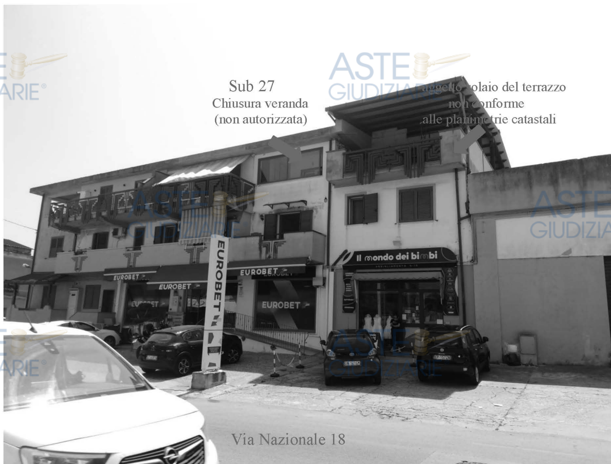
Foto 1_ vista dall'esterno – dalla via Nazionale 18
