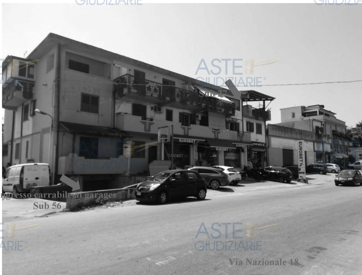
Foto 2_ vista dall'esterno – dalla via Nazionale 18
