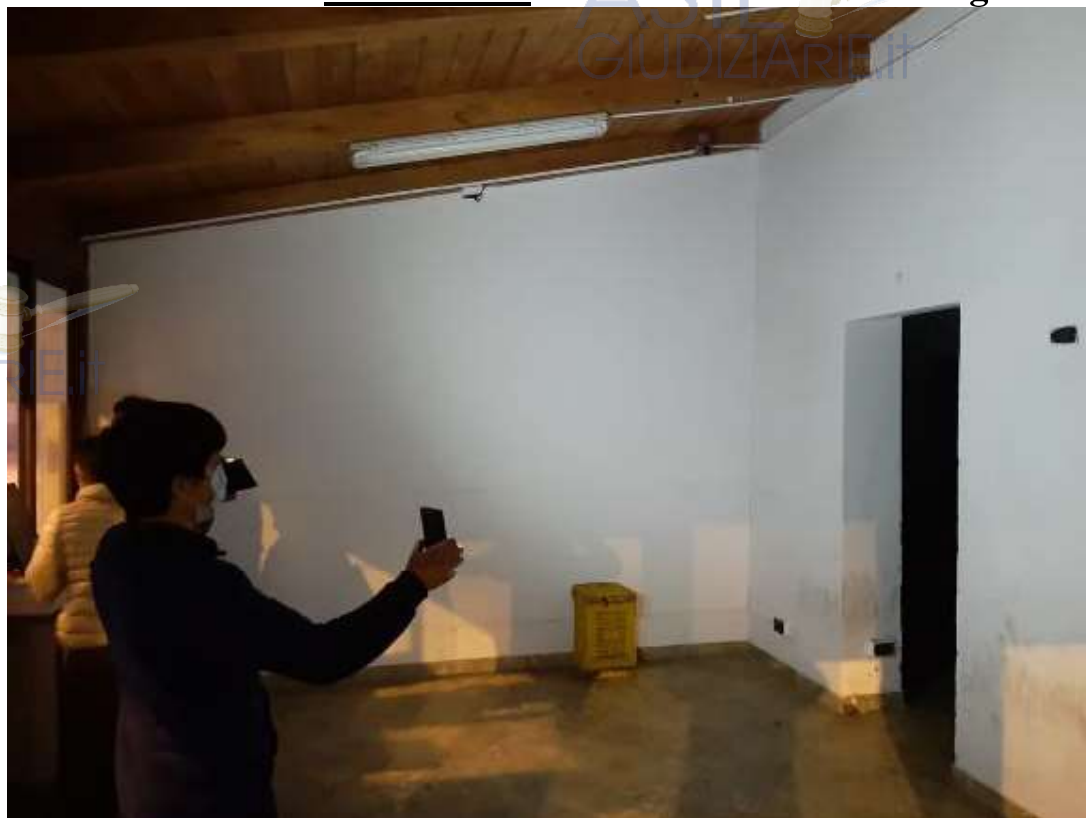
FOTO n. 3 Interno del vano ad angolo
