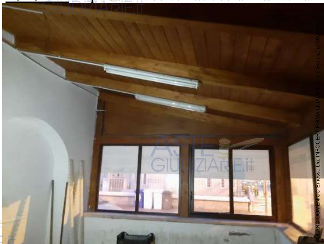
FOTO n. 4 – particolare del soffitto e della finestratura
