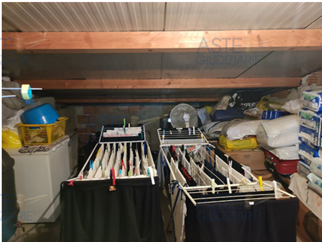
Foto 14: Giffone foglio 3 particella 402 sub. 4 – Sottotetto
