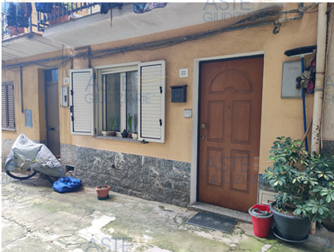
Foto 1: Giffone foglio 3 particella 402 sub. 4 - Facciata principale
