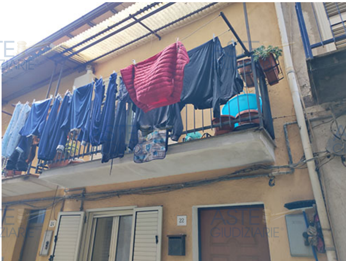
Foto 2: Giffone foglio 3 particella 402 sub. 4 - Facciata principale
