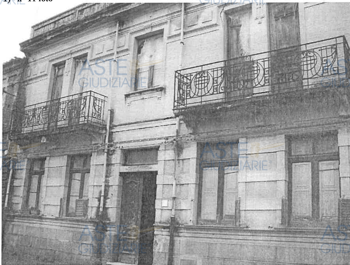
Foto n. 01: Prospetto principale (p. 109)
