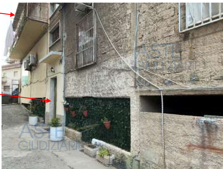
Foto 2: Vista fabbricato dalla corte interna.
