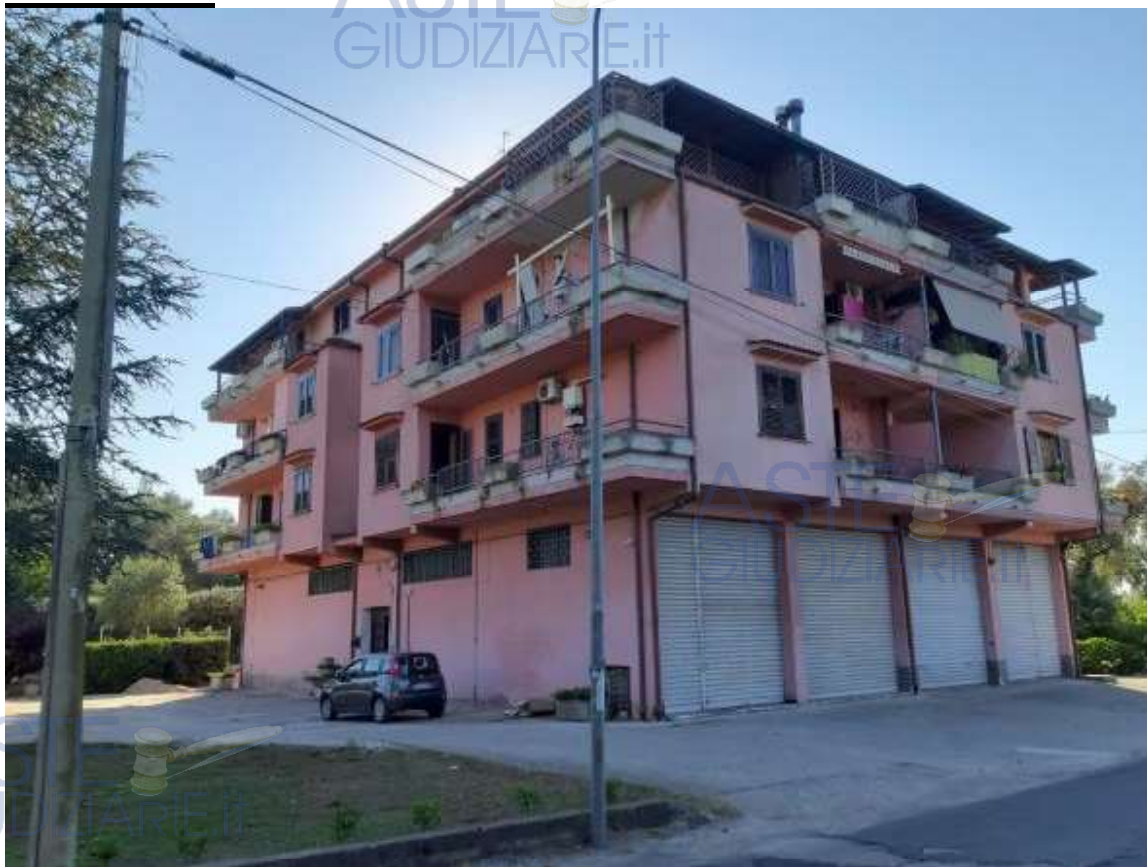
FOTO n. 4 Il Fabbricato visto nel suo insieme
