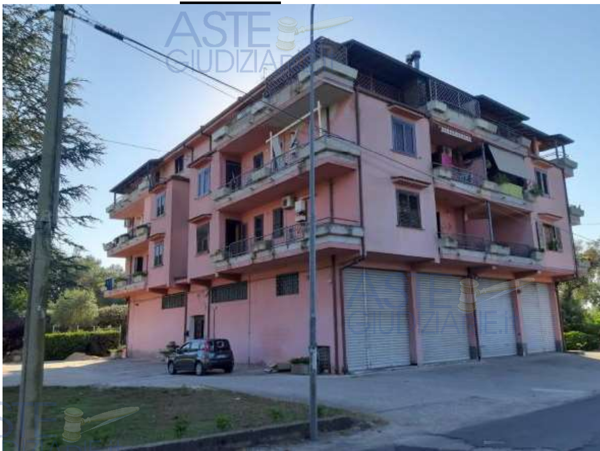
FOTO n.4 - Il fabbricato visto nel suo insieme
