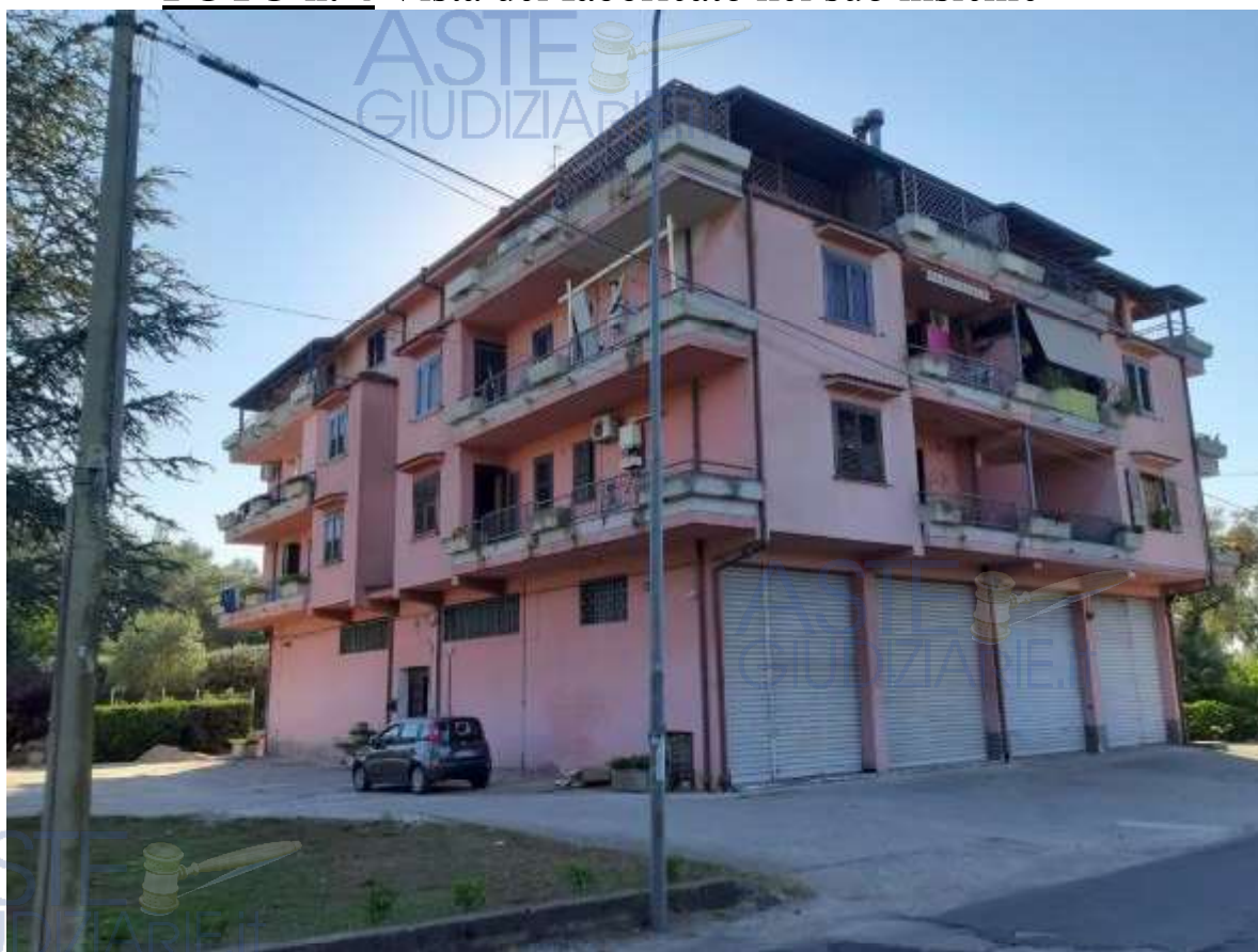
FOTO n. 4 Vista del fabbricato nel suo insieme
