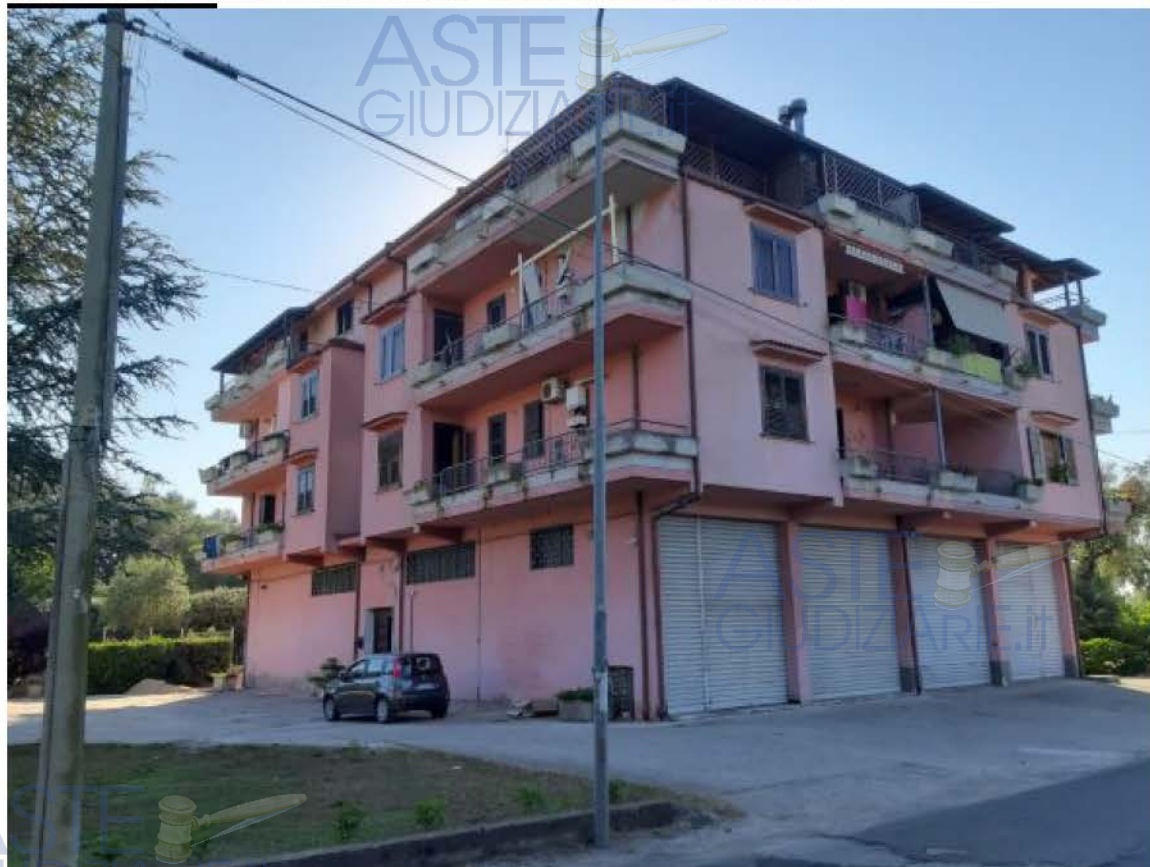
FOTO n. 4 Il Fabbricato visto nel suo insieme
