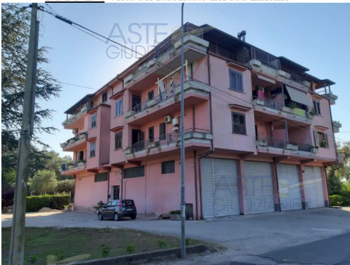
FOTO n. 4 Vista del fabbricato nel suo insieme
