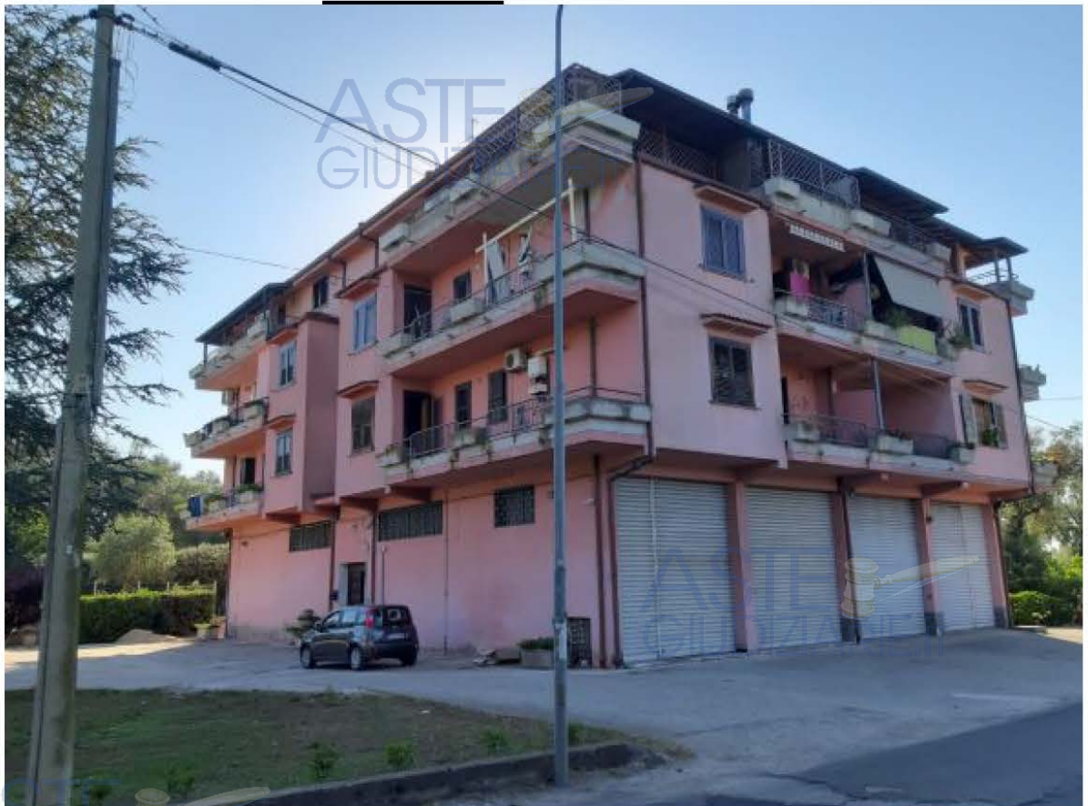
FOTO n.4 - Il fabbricato visto nel suo insieme
