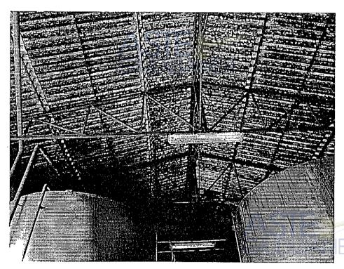
Foto 2: Catasto Fabbricati di Rizziconi, foglio 32, particella 590 – copertura di cemento-amianto vista dall'interno del fabbricato.
