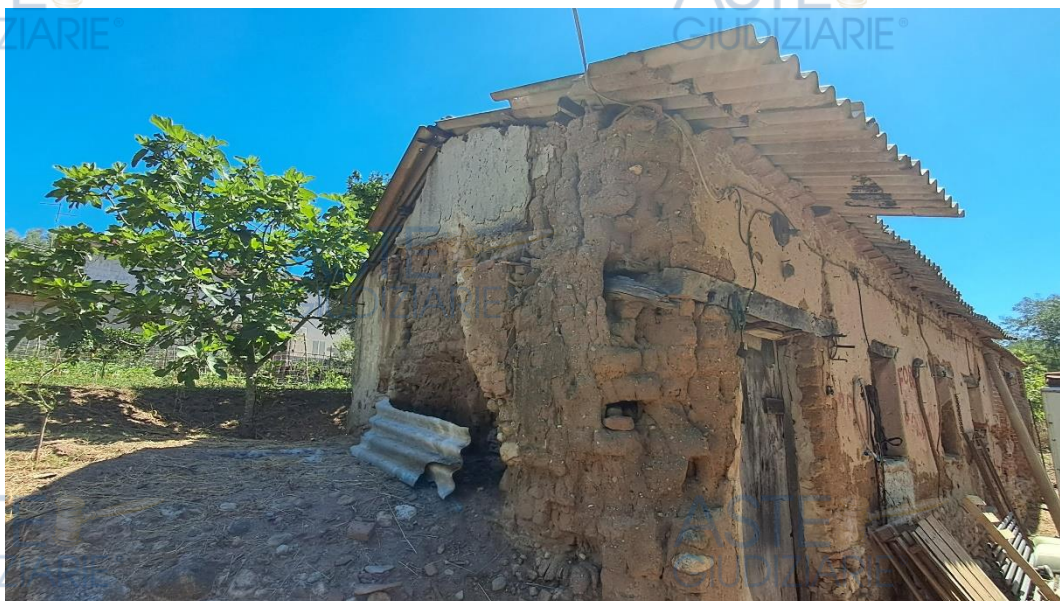
Foto 5: Catasto Terreni di Feroletto della Chiesa, foglio 11, particella 57 – fabbricato in rovina, realizzato in epoca remota con struttura in muratura ordinaria in blocchi di terra e copertura a falde inclinate, presenta una porzione del tetto di circa 45,00 mq rivestito con lastre ondulate di cemento amianto.
