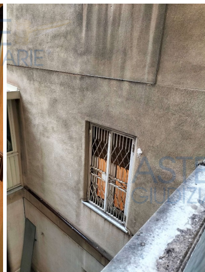
Foto 12 - Pozzo luce visibile dal corridoio
