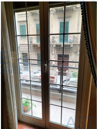
Foto 7 - Infisso su prospetto principale
