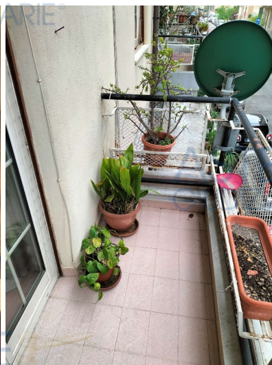
Foto 6 - Balcone su via p. Amato
