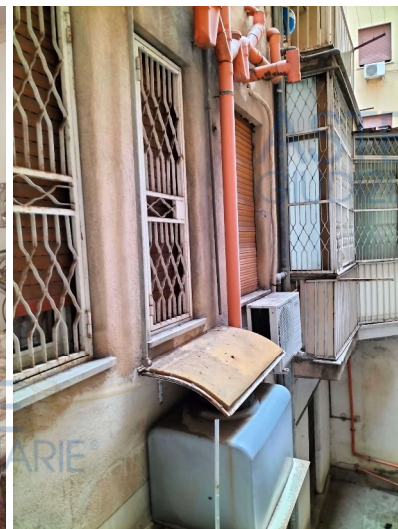
Foto 21 – Colonna di scarico sul pozzo
