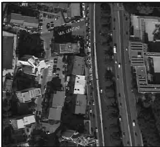
- Foto n°1 = Vista aerea del compendio dei fabbricati ad edilizia popolare.
