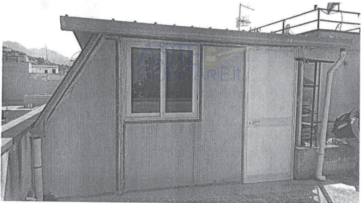
Struttura da demolire
