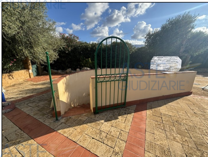
Foto 12 – Scala di accesso ai locali tecnici
