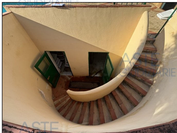
Foto 13 – Veduta dei locali tecnici interrati
