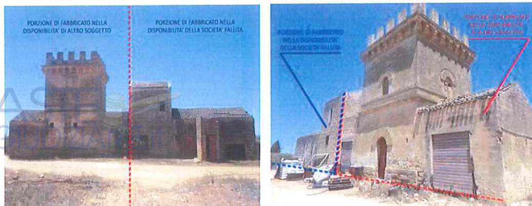
Figura 8 – Vista esterna del corpo di fabbrica censito al N.C.T. del comune di Petrosino, al foglio 78, p.lla 5, sub.1 e 2. A sinistra immagine lato prospiciente proprietà della società fallita, a destra immagine del fabbricato lato prospiciente altra proprietà.
