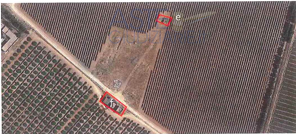
Figura 7 – Individuazione su base ortofoto degli edifici indicati ai punto “e” ed “f”
