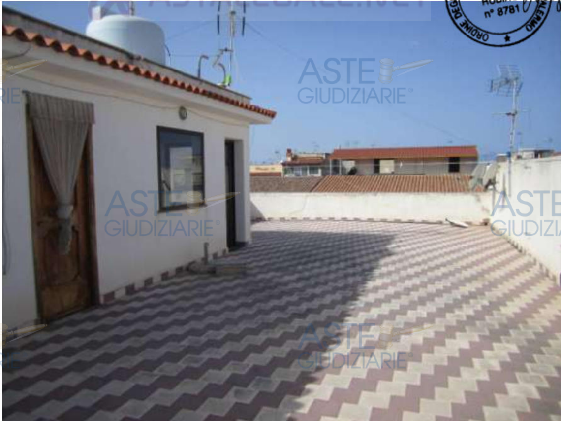
Foto n. 18 – piano terzo, terrazza
