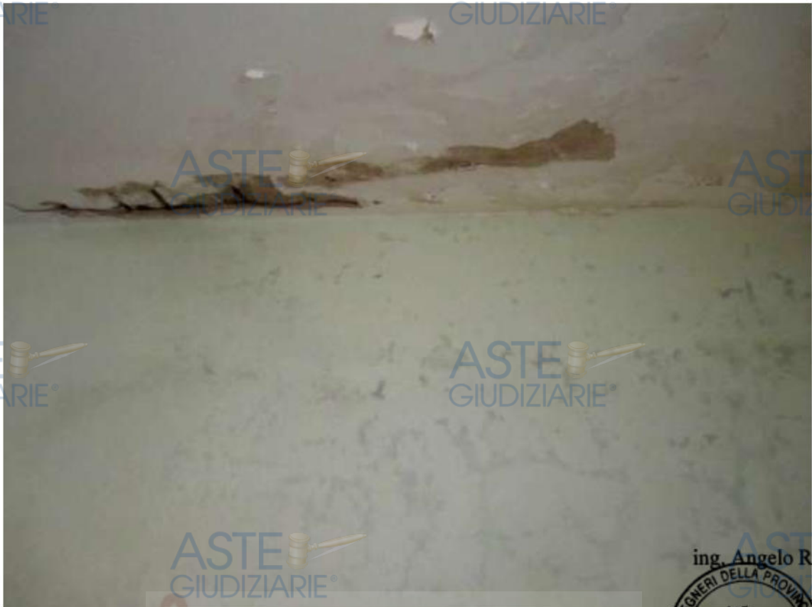
Foto n.13 – piano secondo, camera da letto 2, particolare soffitto
