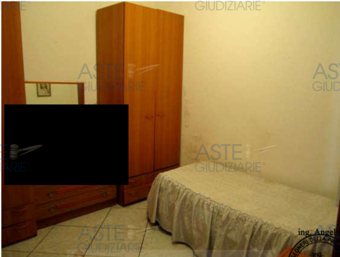
Foto n.7 – piano seminterrato, camera da letto
