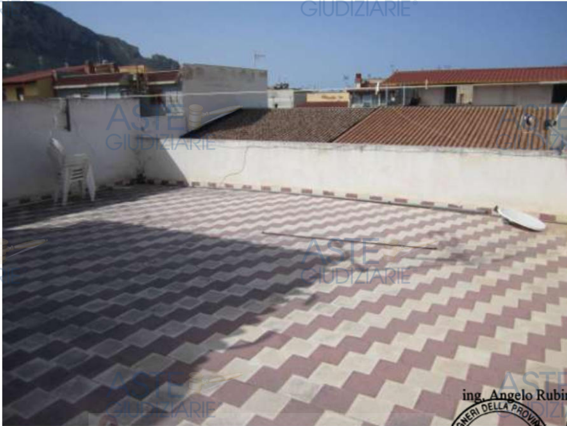
Foto n.19 – piano terzo, terrazza
