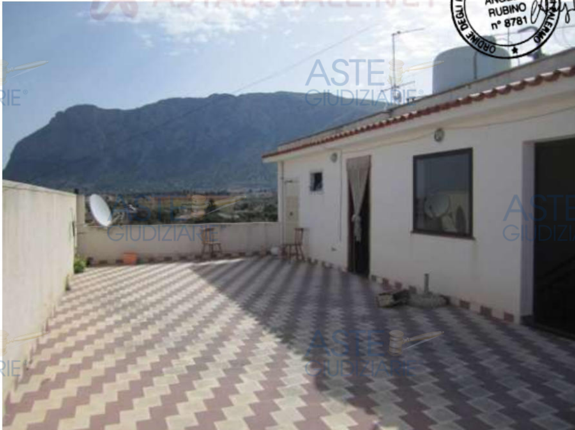
Foto n.20 – piano terzo, terrazza
