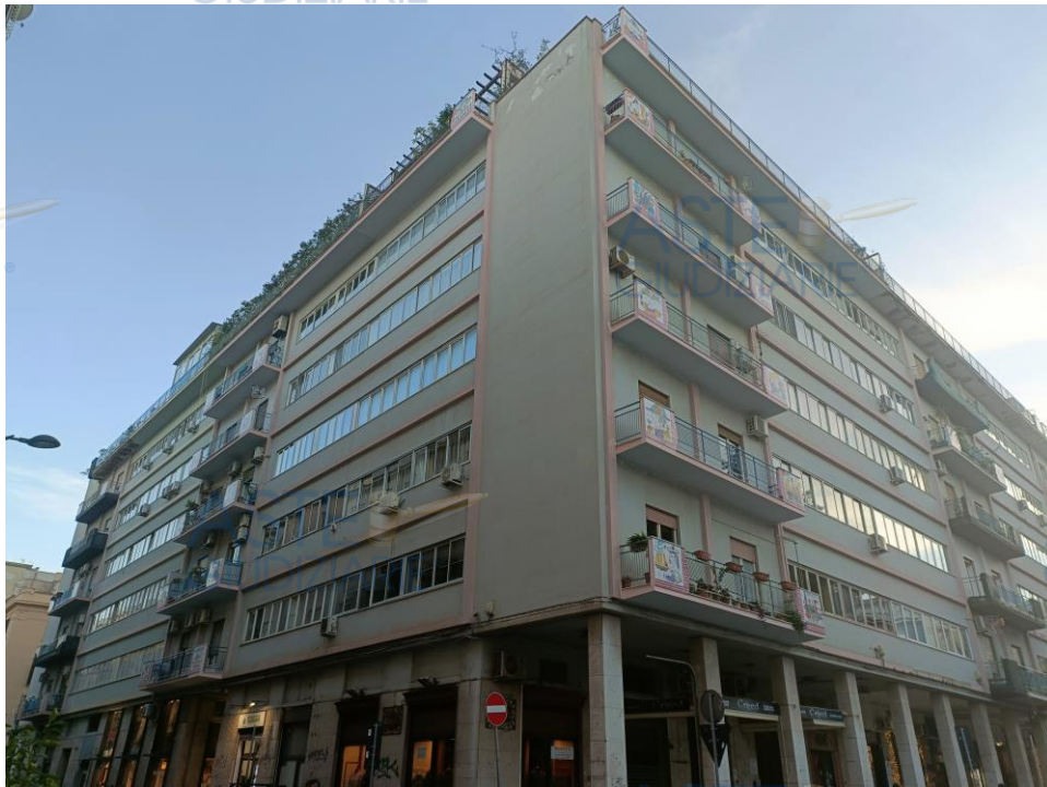
Foto nn. 1-2 Vista dell'edificio condominiale e dell'androne di via Enrico Onufrio n. 8
