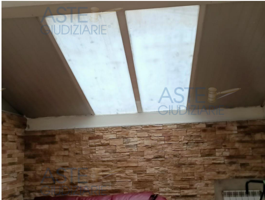
Foto n. 11-12 – Cucina creata su terrazzo con copertura in profilati metallici e pannelli coibenti
