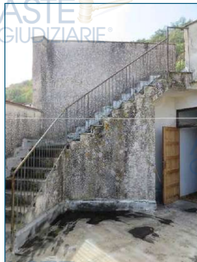
Scala di accesso alla terrazza di terzo piano (lastrico solare)
