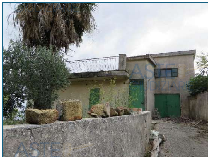
Corpo di fabbrica principale
