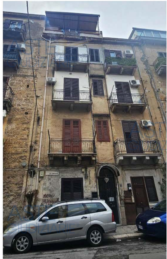
Foto n. 5: Via Re Tancredi n. 62
