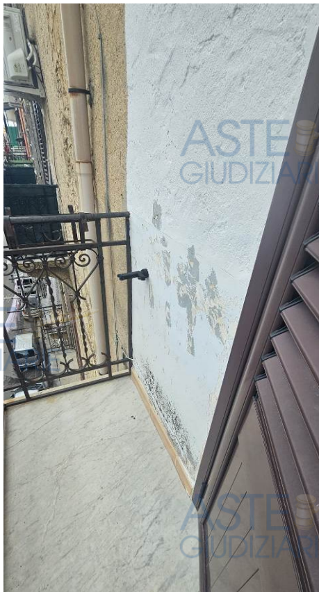
Foto n. 26: degradi su prospetto via Re Tancredi
