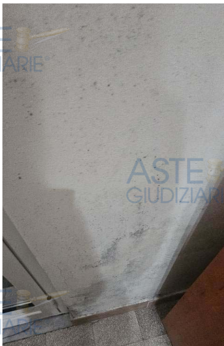
Foto n. 24: tracce di umidità in camera da letto
