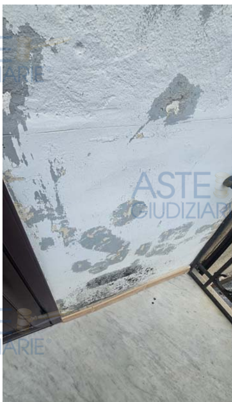
Foto n. 28: degradi su prospetto via Re Tancredi
