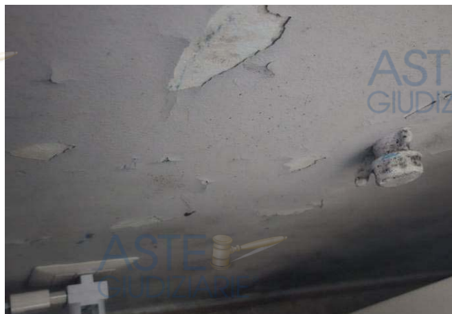
Foto n. 25: tracce di umidità nella cameretta
