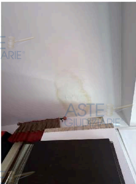
Foto n. 8 – L'infiltrazione sul tetto della cucina
