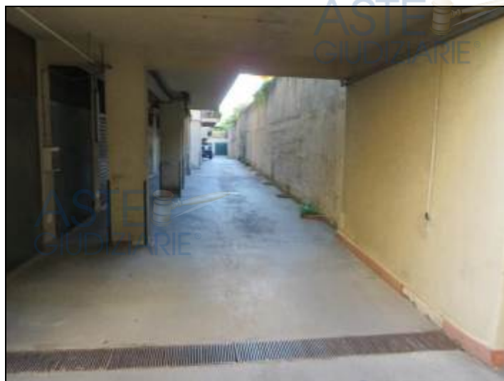
Corsia di manovra (sub. 91)
