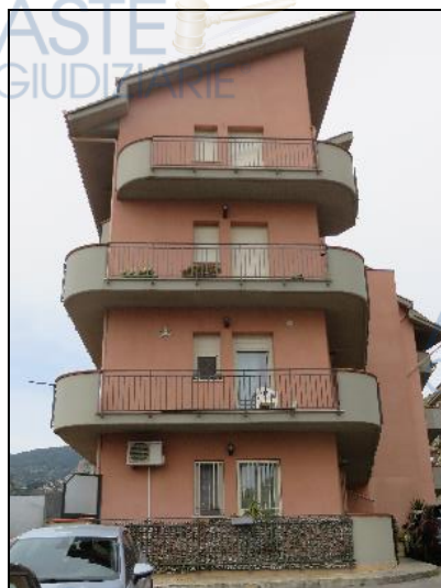
Prospetto laterale dell'edificio
