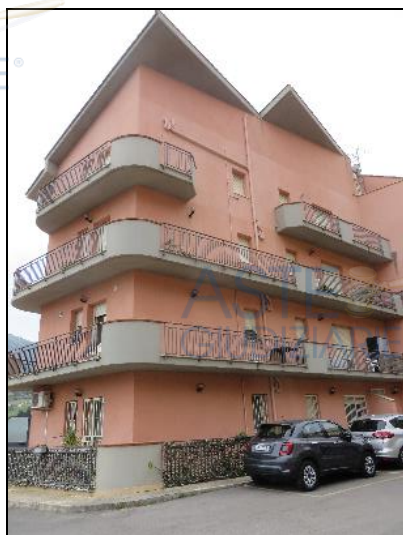
Prospetto principale dell'edificio
