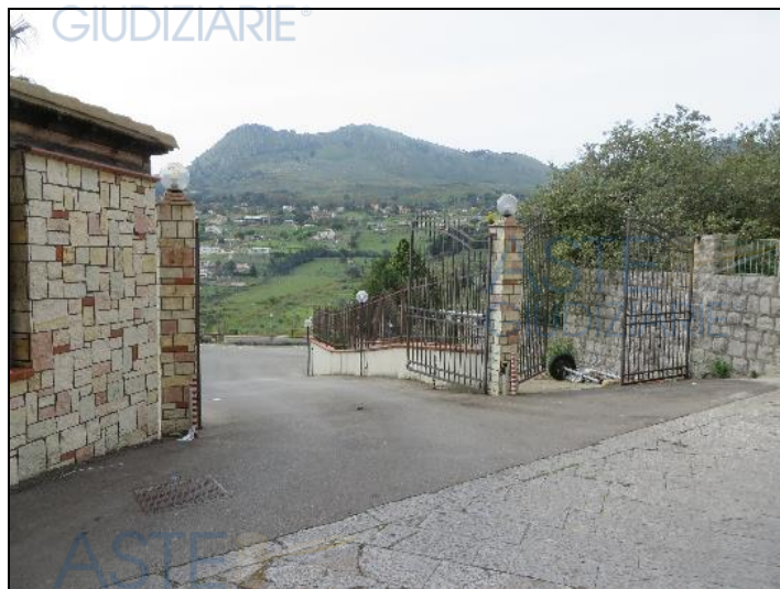
Cancello di ingresso al complesso edilizio
