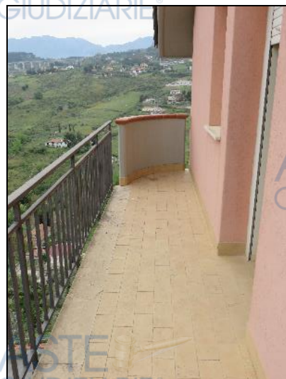
Balcone posto sul prospetto laterale
