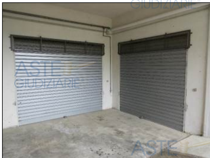
Saracinesche di ingresso all'unità immobiliare
