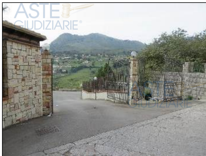
Cancello di ingresso al complesso edilizio
