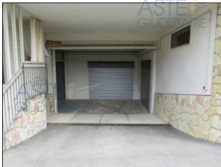
Accesso all'unità immobiliare dal sub. 116
