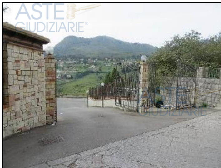
Cancello di ingresso al complesso edilizio
