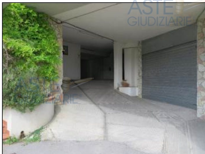
Accesso alla corsia di manovra del garage di piano S1
