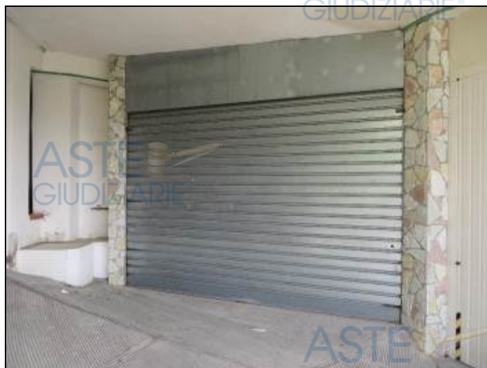
Ingresso dell'unità immobiliare
