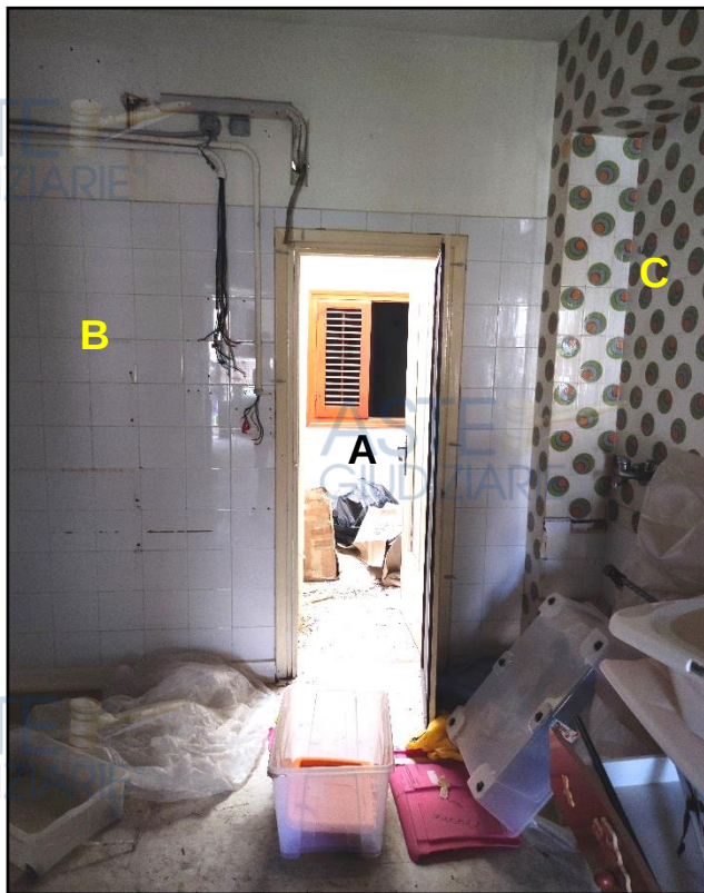
Foto N°15 - Camera 2: (A) pozzo luce; (B) rivestimento parietale con piastrelle ceramiche cm. 20 x 20 per H = m.2,30
