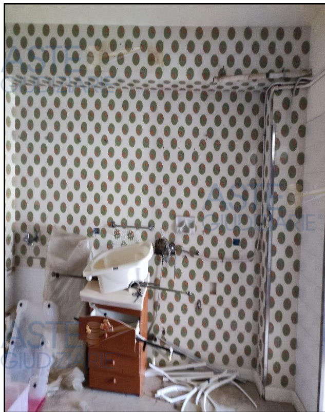
Foto N°16 - Camera 2: part. rivestimento parietale con piastrelle per H= m. 3,05
