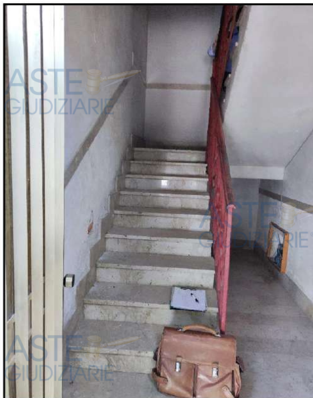
Foto N°4 - Part.interno androne : rampe con gradini in marmo , protette da ringhiera metallica
