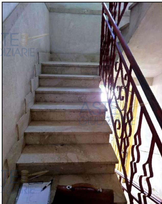
Foto N°7 - Rampa di accesso con gradini in marmo
