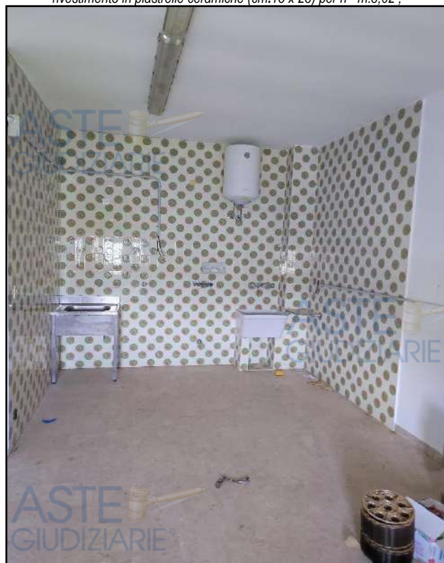
Foto N°16 - Cucina - Soggiorno : pavimento in marmette di Perlato ( cm.25 x 50) rivestimento parietale con piastrelle ceramiche (cm.20 x 20) per h = m.3,02
