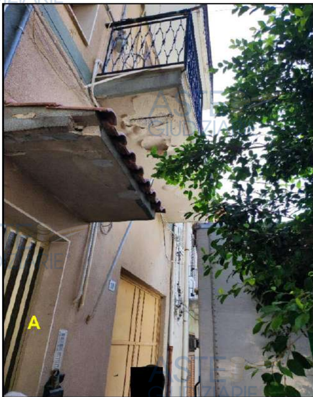
Foto N°1 - (A) Accesso all'unità immobiliare di Largo Villa Migliore N°18
