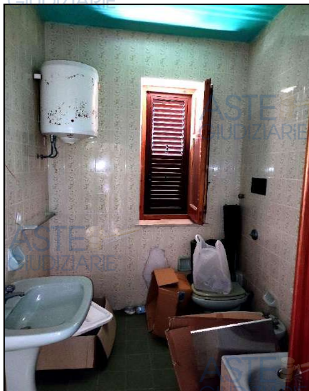
Foto N°14 - W.C. Bagno : pavimento in piastrelle ceramiche (cm.20 x20) rivestimento in piastrelle ceramiche (cm.15 x 23) per h= m.3,02 ;
