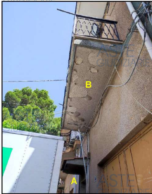
Foto N°2 - (A) Ingresso ; (B) Balcone Laboratorio sub.12
